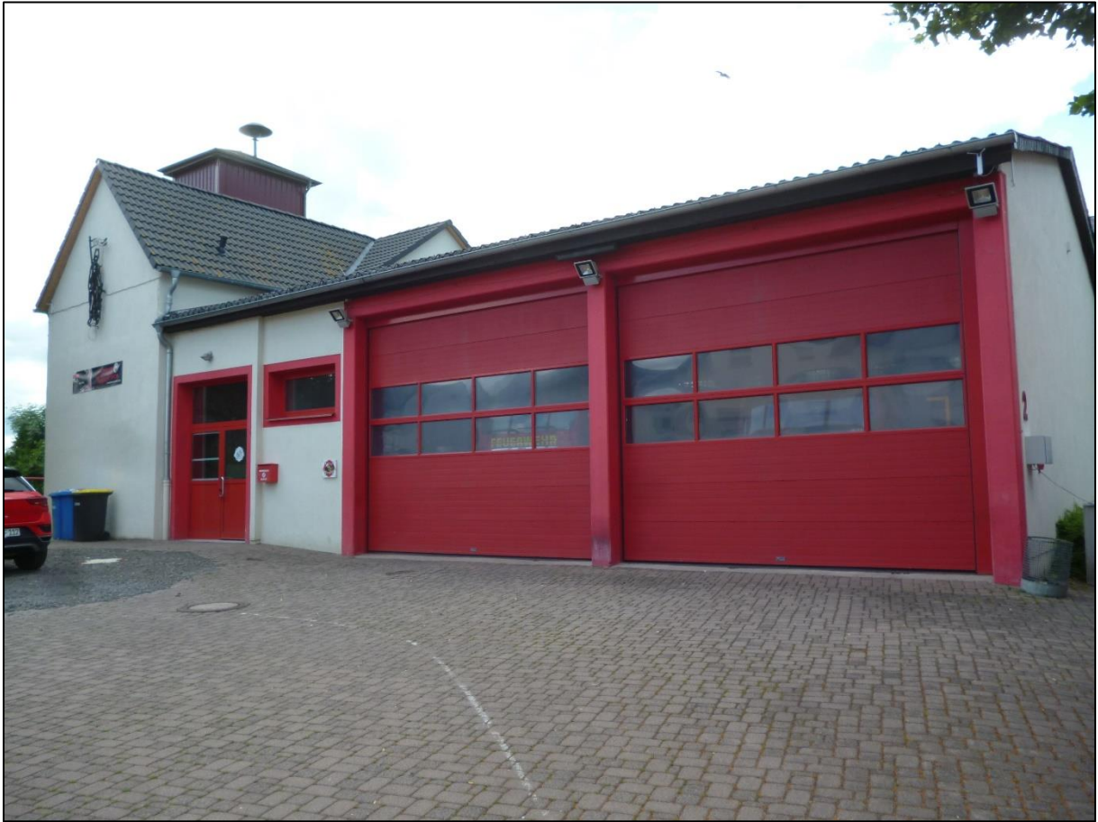
Abbildung 4.2 Feuerwehrhaus Einsatzabteilung Kettenbach
