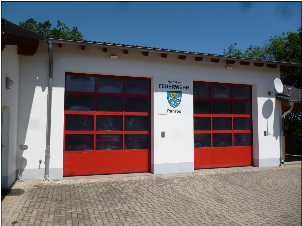
Abbildung 4.8 Feuerwehrhaus Einsatzabteilung Panrod
