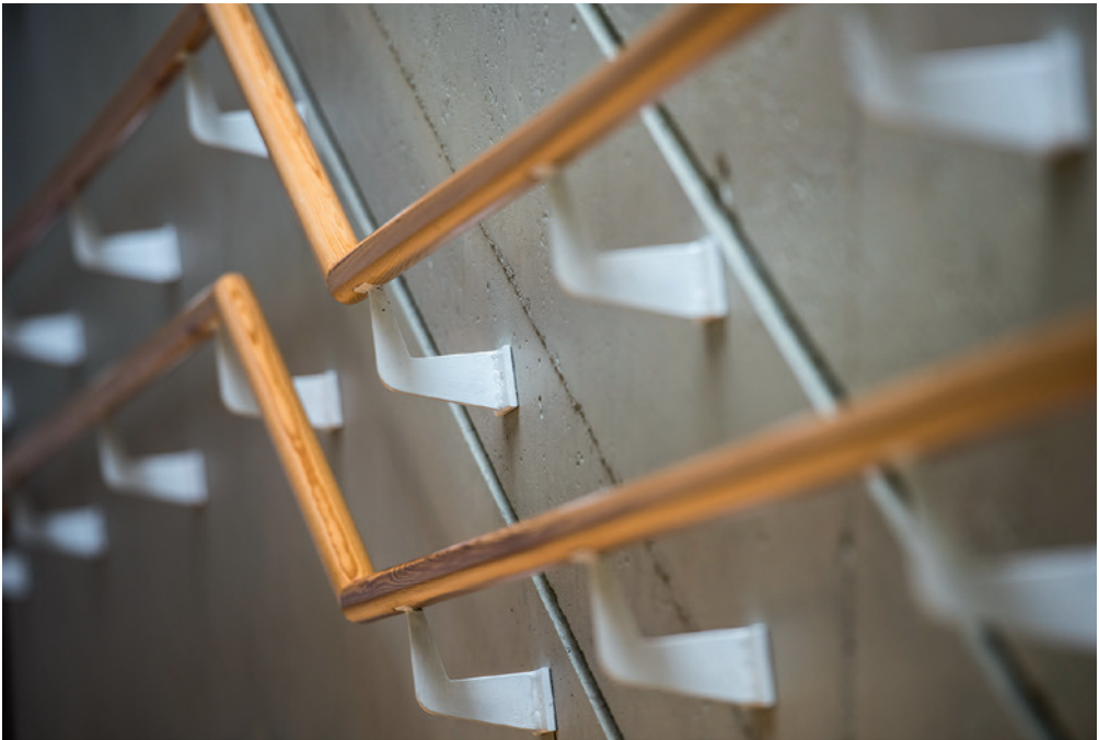
Foto 1: Unterschiedliche Handlaufhöhen für Kinder und Erwachsene
