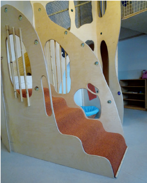
Foto 23: Wellentreppe und Brüstungselement als Aufstiegshilfe
