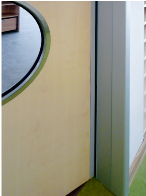
Foto 13 und Foto 14: Zarge ohne Quetschgefahren an der Bandseite
