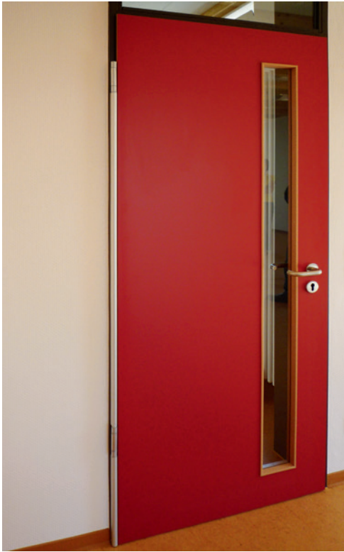
Foto 11 und Foto 12: Beidseitige Abdeckung der Nebenschließkante
