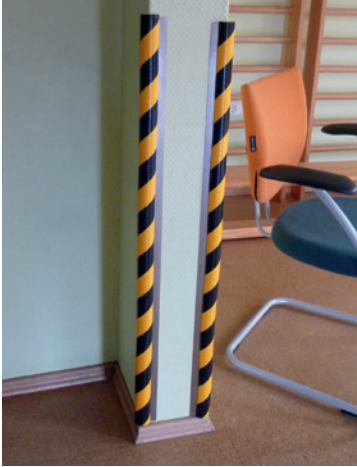
Foto 29 und Foto 30: Kantenabdeckung im Bewegungsraum
