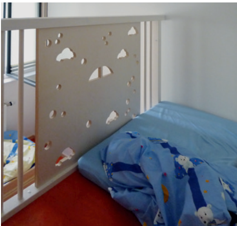
Foto 24: Umwehung einer Spielebene mit unzulässigen Öffnungen, weil diese ein Beklettern der Brüstung ermöglichen
