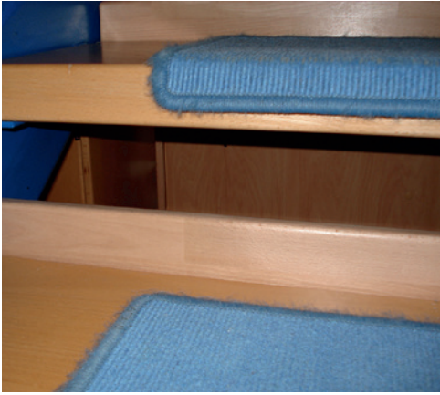
Foto 7: Treppe mit Aufkantungen zur Verringerung der Öffnungsweite zwischen den Stufen
