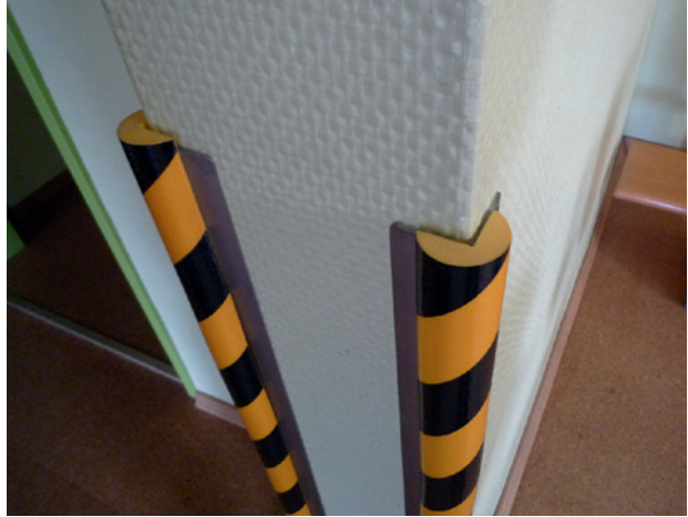
Foto 29 und Foto 30: Kantenabdeckung im Bewegungsraum
