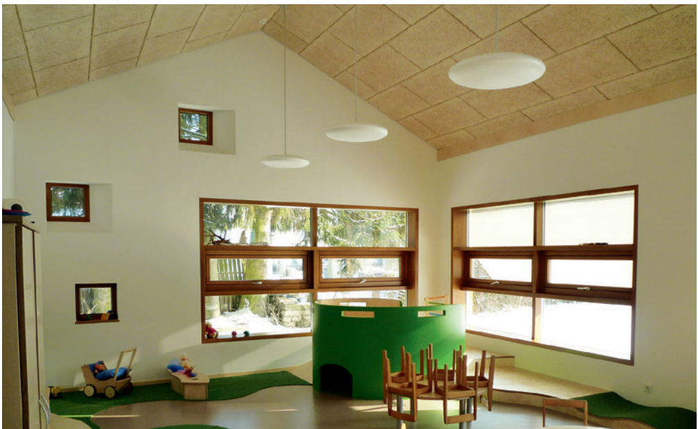
Foto 5: Deckenkonstruktion aus Holzfasernplatten in einem Gruppenraum
