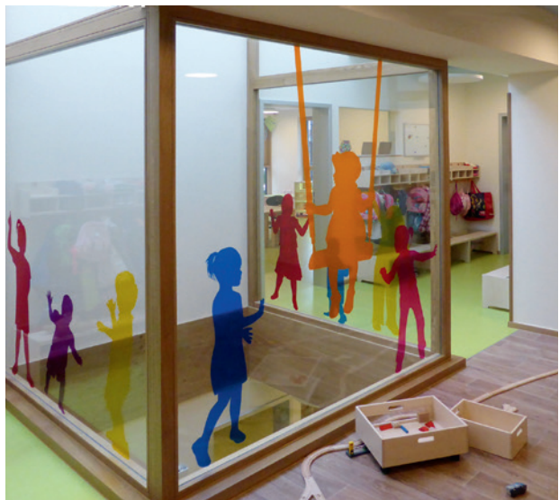
Foto 21: Kennzeichnung einer Glasfläche im Bewegungsraum
