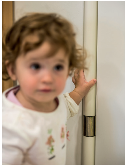
Foto 13 und Foto 14: Zarge ohne Quetschgefahren an der Bandseite
