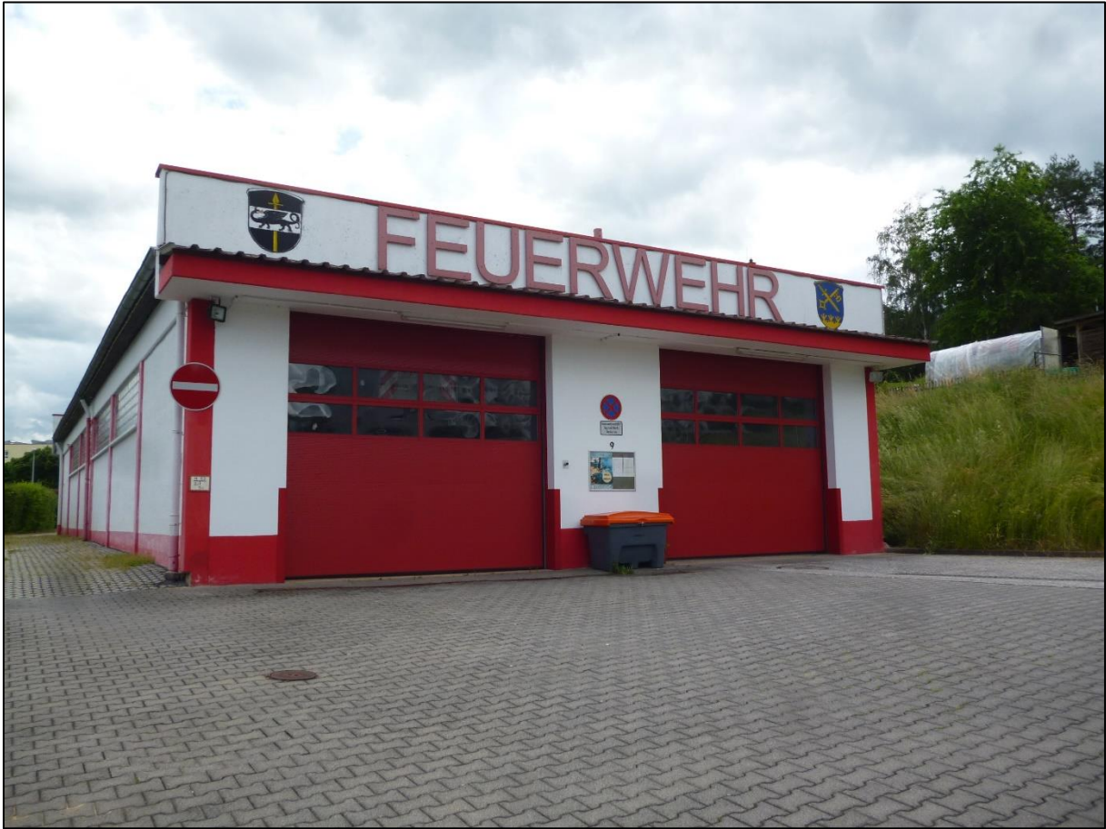
Abbildung 4.4 Feuerwehrhaus Einsatzabteilung Michelbach
