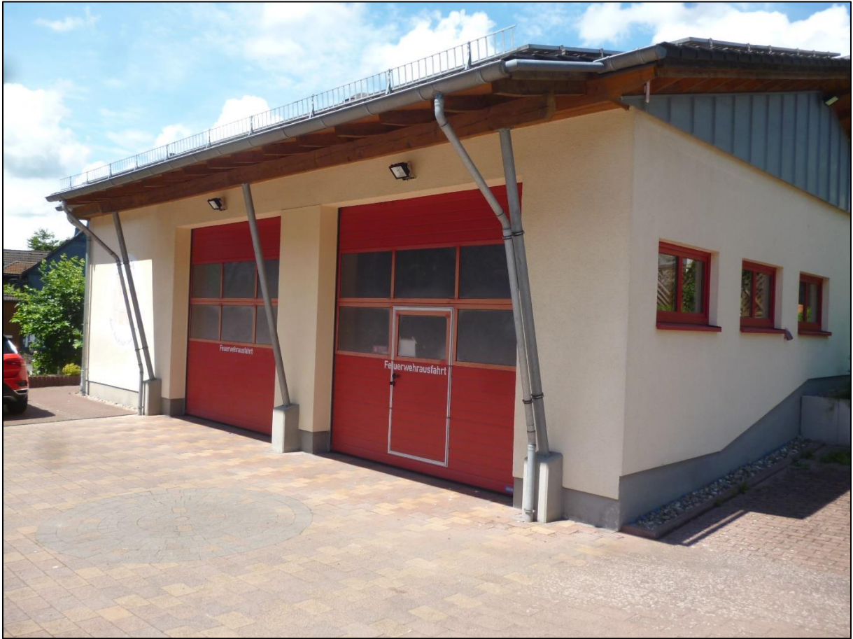
Abbildung 4.10 Feuerwehrhaus Einsatzabteilung Daisbach
