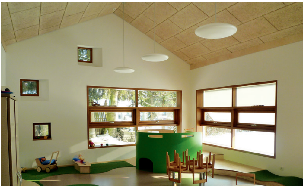
Foto 5: Deckenkonstruktion aus Holzfasernplatten in einem Gruppenraum
