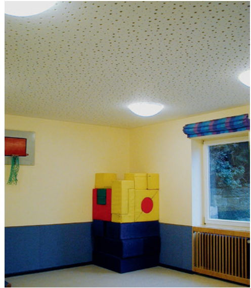
Foto 6: Deckenkonstruktion aus Gipskartonlochplatten mit ungleichmäßiger Lochung in einem Bewegungsraum
