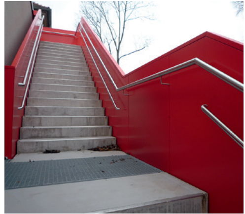
Foto 9: Außentreppe als zweiter Fluchtweg
