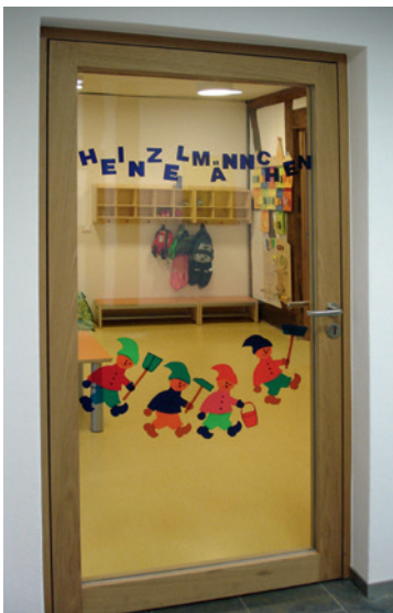
Foto 20: Kennzeichnung einer Glasscheibe an einer Tür
