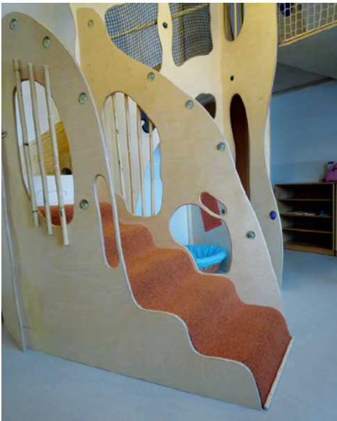
Foto 23: Wellentreppe und Brüstungselement als Aufstiegshilfe
