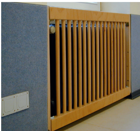
Foto 22: Abdeckung eines Stahlgliederheizkörpers in einem Mehrzweckraum
