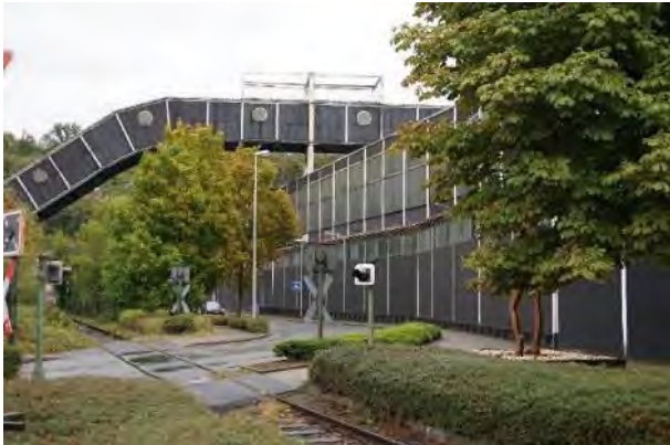
Abb. 92: Michelbacher Hütte, ACO Betonbereich 42
