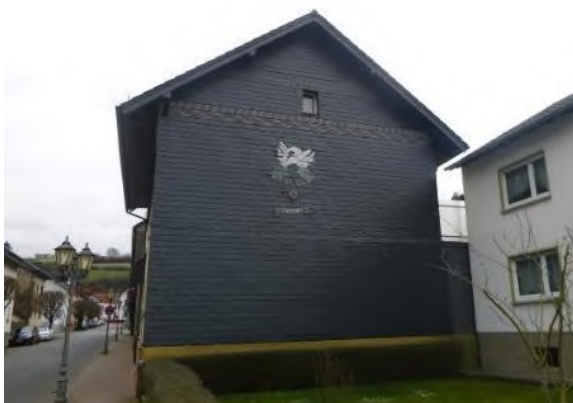
Abb. 32: Hausfassade mit vollflächiger Schieferverkleidung an einer Firstseite
