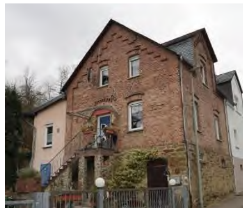
Abb. 33: Wohngebäude mit Untergeschoss aus massivem Bruchsteinmauerwerk und OG/DG in Backstein mit Schmuckelementen
