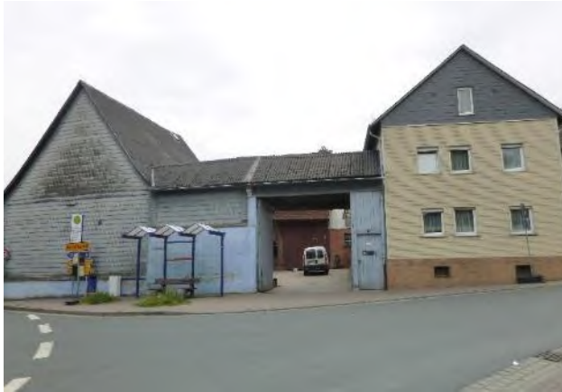
Abb. 28: Hofreite mit (Kunst-)Schieferverkleidung und Kratzputz
