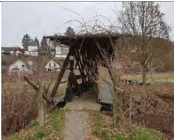
Hausen: Brücke über den Bach
