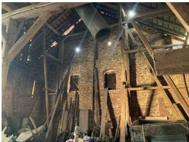
Abbildung 57: Blick in den hallenartigen Westtrakt
