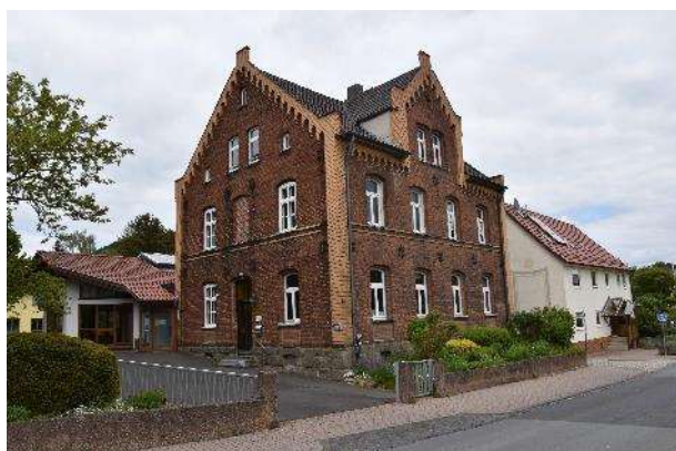
Abbildung 66: Altbau des Gemeindezentrums mit Anbau
