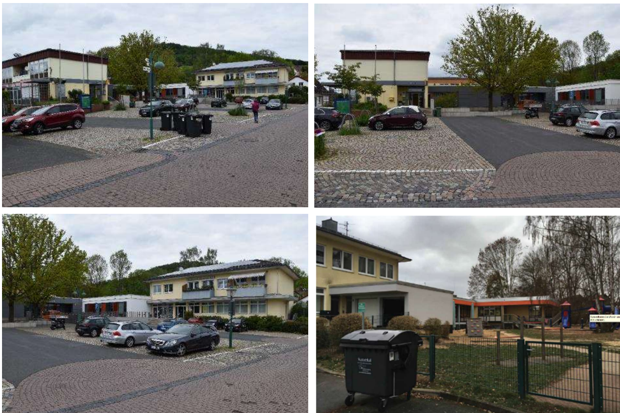
Abbildung 64: Gemeindezentrum mit Kindergarten
