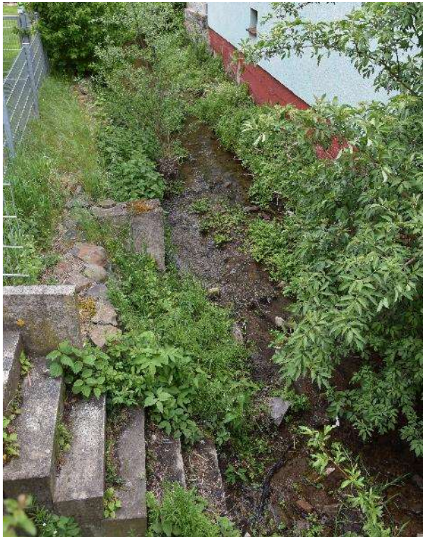
Abbildung 42: Servitutgraben im Kreuzungsbereich Steinweg
