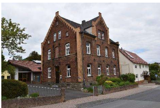
Abbildung 14: Altbau des Gemeindezentrums mit Anbau
