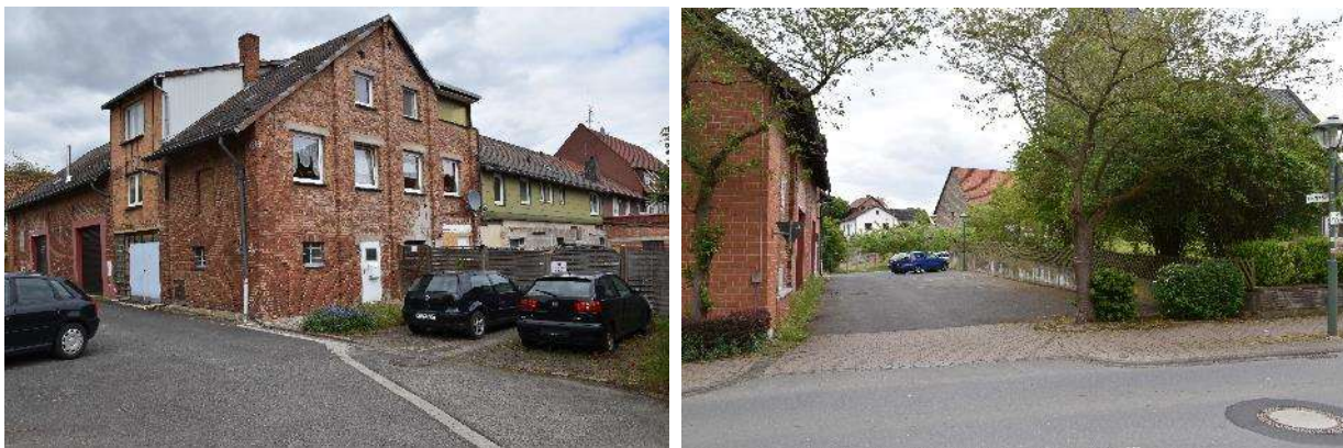
Abbildung 39: Parkplatz im Verlauf der Kirchgasse
