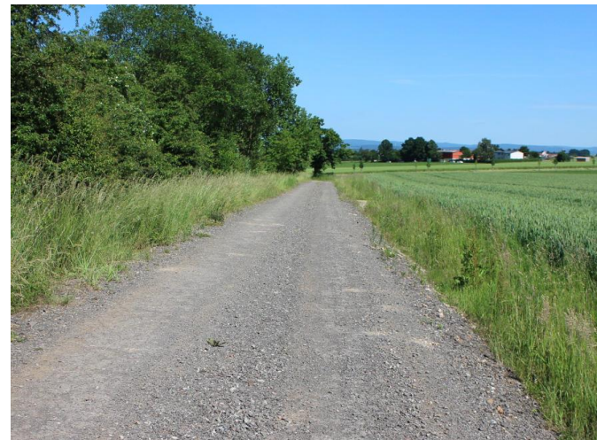
Schotterstrecke mit Blickrichtung Vellmar
