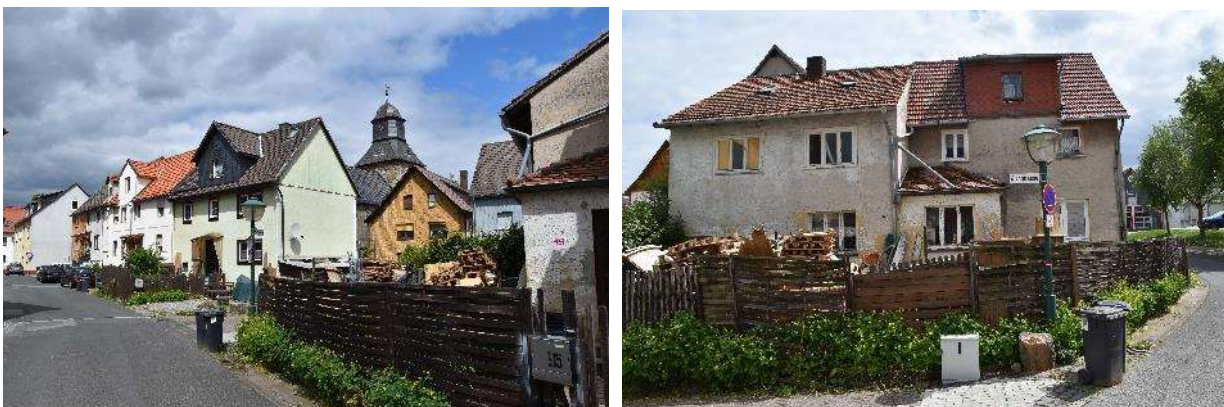
Abbildung 13: Straße Am Rain als Rest der historischen Siedlungsstruktur mit erheblichem Sanierungsbedarf
