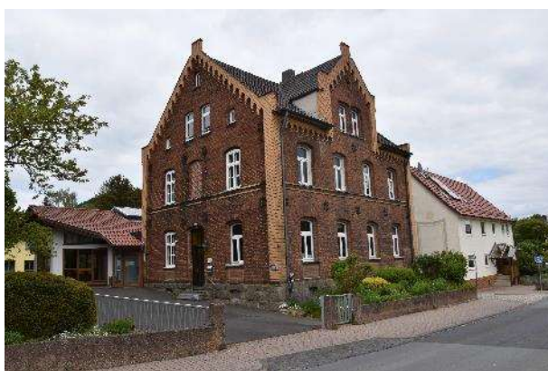
Abbildung 14: Altbau des Gemeindezentrums mit Anbau
