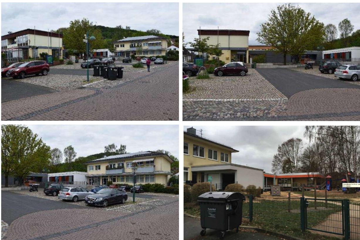
Abbildung 64: Gemeindezentrum mit Kindergarten
