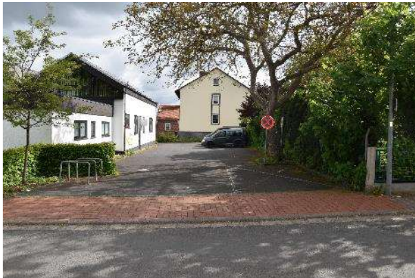
Abbildung 46: Stellplatzanlage des Bürgersaals mit unzureichender Ausleuchtung und Gestaltungsdefizit
