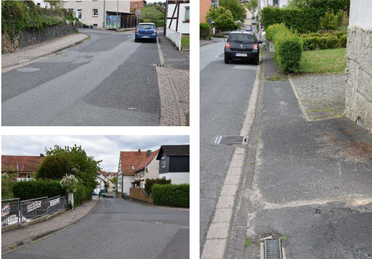
Abbildung 31: Verschiedene Defizite der innerörtlichen Fußwegeverbindungen
