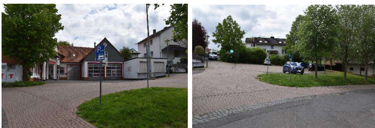
Abbildung 65: Der ehemalige Feuerwehrstandort beherbergt heute eine Rettungsstation des DRK. Der angrenzende ehemalige Feuerwehrparkplatz stellt eine innerörtliche Entwicklungsfläche dar.
