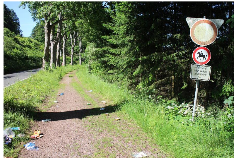
Der obere Beginn der Ausbaustrecke entlang der K29.
