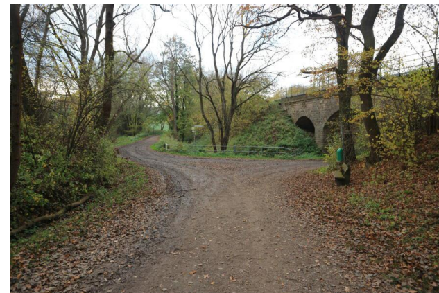
Nördliches Maßnahmenende nahe der Bahn.
