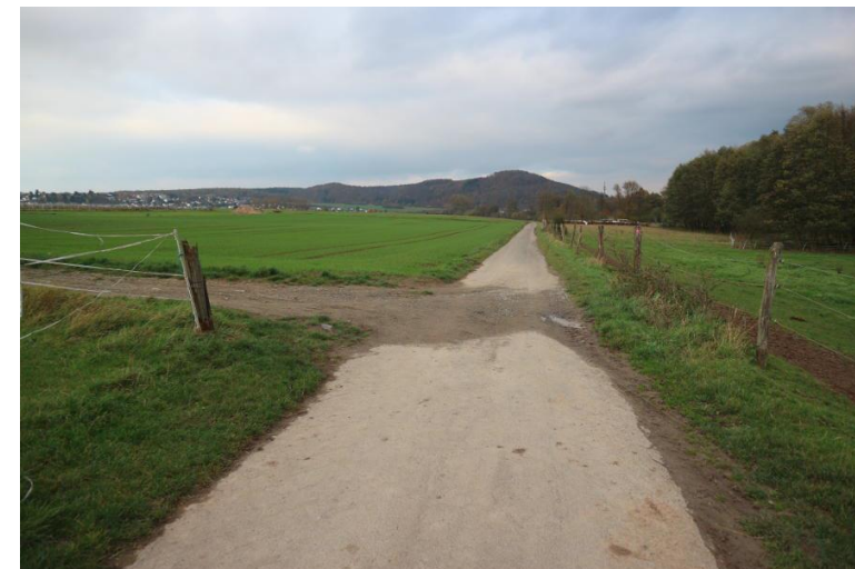
Asphaltweg mit seitlichem Schottereintrag
