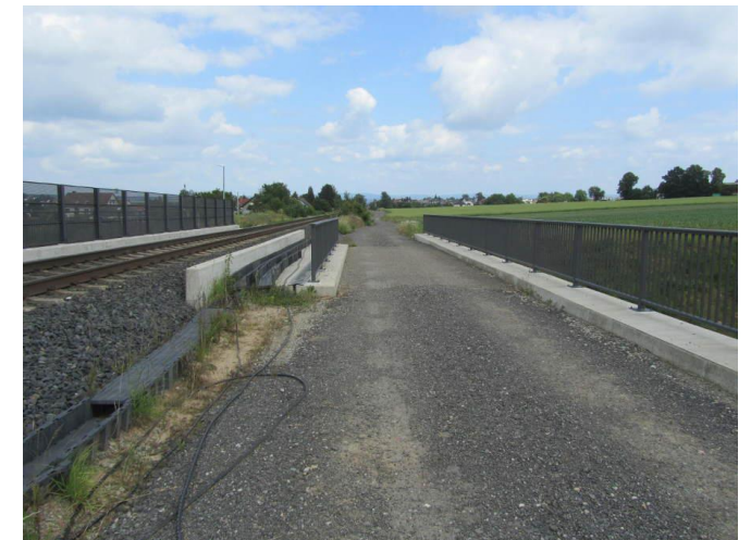
Schotterstrecke auf der Überführung Rasenallee.
