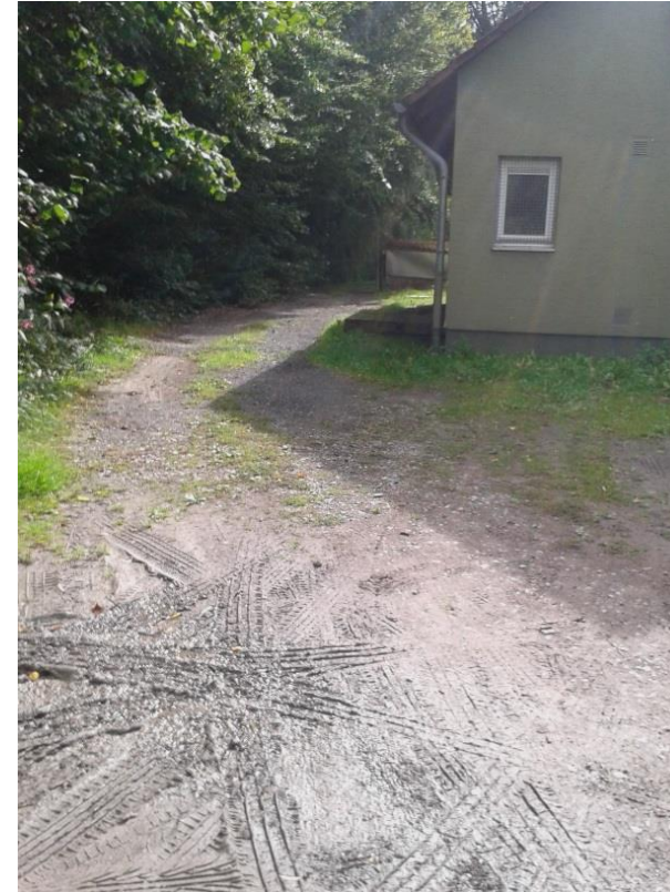
EAM-Gebäude an der Kreisstraße
