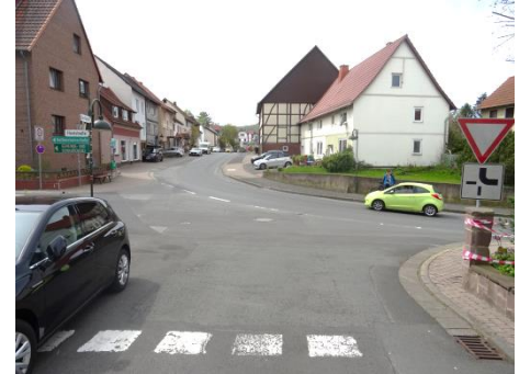
Neubau Querungsanlage Dörnbergstraße
