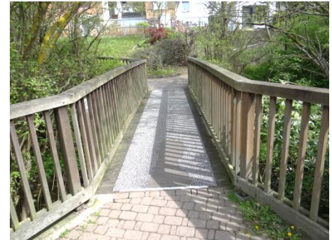
Holzbrücke über Ahne
