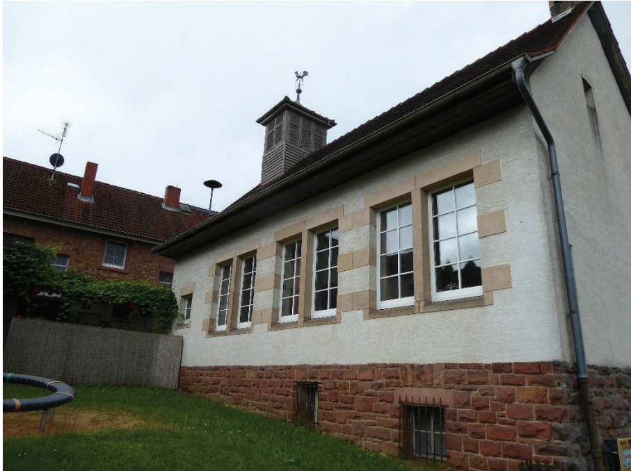
Östliche Ansicht des Objektes
