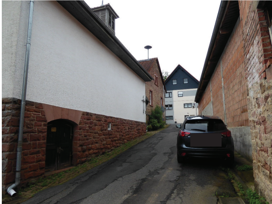
Westliche Ansicht des Objektes
