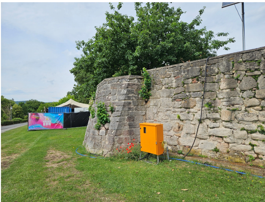
Abb. 2: Vorgesehene Sondergebietsfläche an der Stadtmauer (Foto Stadt BSA)
