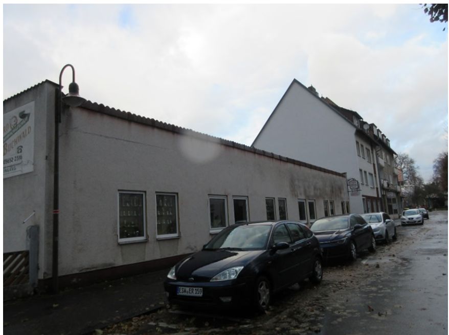
Abbildung 7: Bebauung im nördlichen Bereich, Kegelzentrum im Vordergrund
