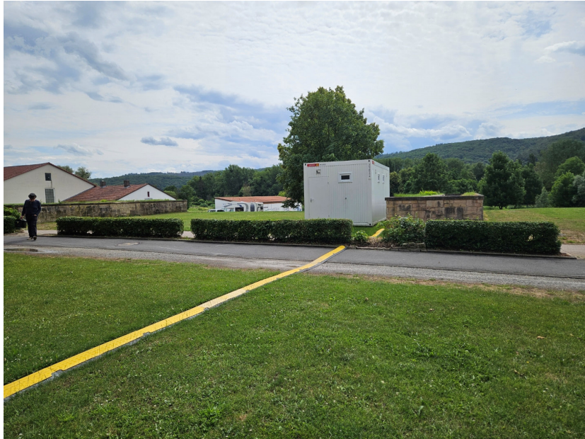
Abb. 3: Regenrückhaltefläche – vorgesehen Standort für temporäre Sanitärcontainer (Foto Stadt BSA)
