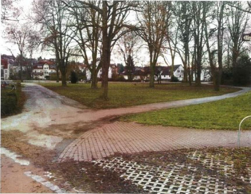
Für den zweiten Änderungsvorschlag wird empfohlen zu prüfen, ob eine Ausführung wie beim Niddauerweg mit 3 Metern breiter Asphaltstrecke für Fahrradfahrer und 2 Meter breiter Pflasterung für Fußgänger platztechnisch realisierbar ist. Falls dies nicht der Fall sein sollte, wird ein gemeinsamer mindestens 4 Meter breiter Fuß- und Radweg empfohlen.
