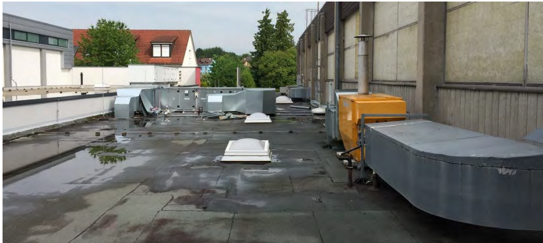
Anbau (westliche Hallenwand)
