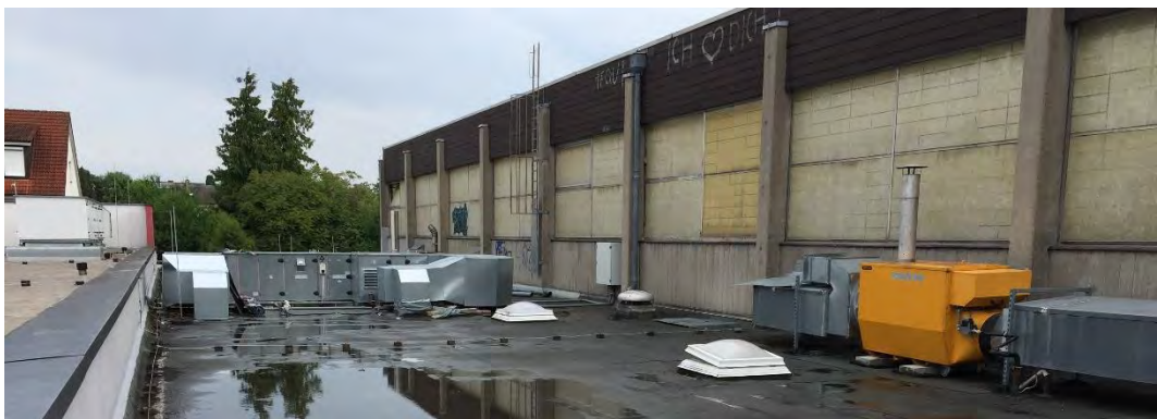
Flachdach Anbau inkl. Lüftungsanlagen
