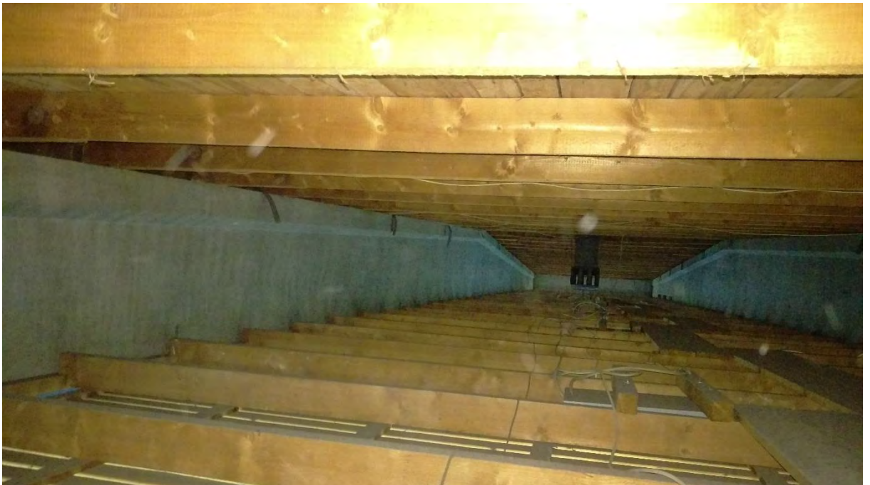
Abbildung 2 Blick zwischen Dach- und Unterdecke
