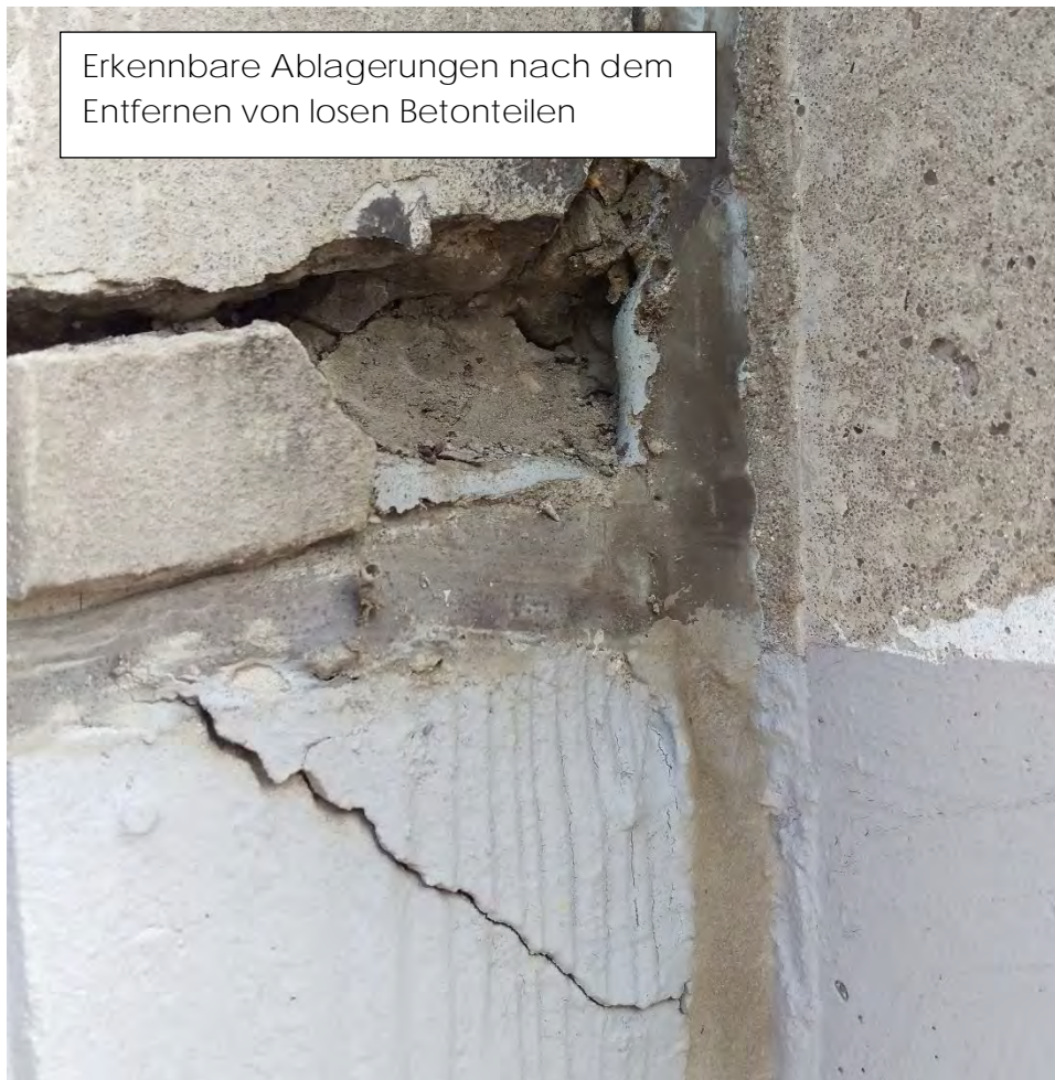
Abbildung 11 Anschluss Betonwand an Stütze
