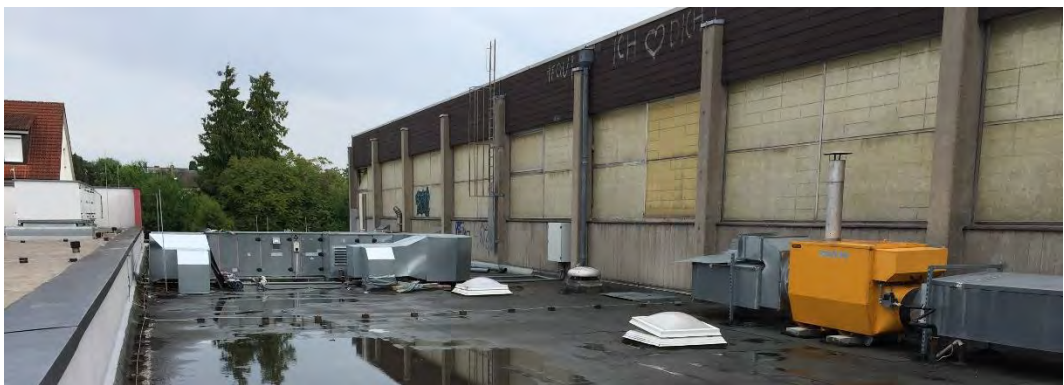
Flachdach Anbau inkl. Lüftungsanlagen
