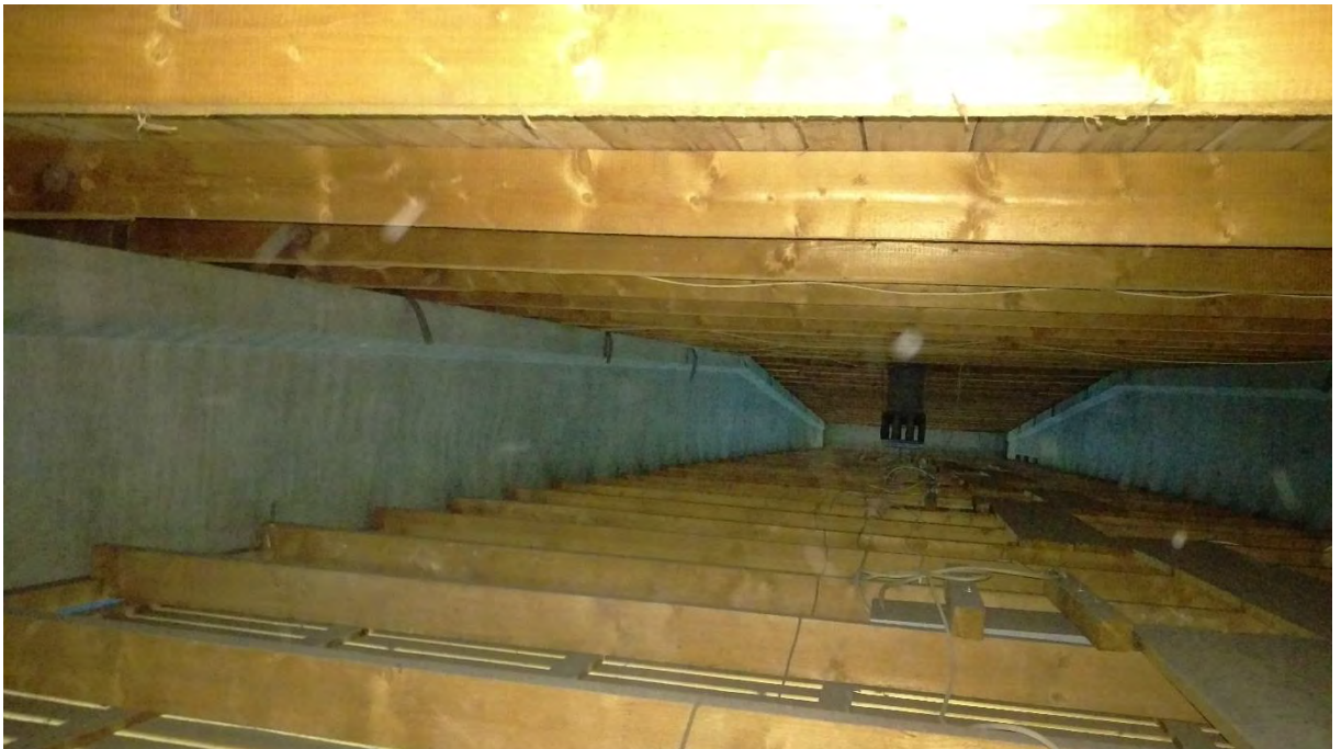
Abbildung 2 Blick zwischen Dach- und Unterdecke
