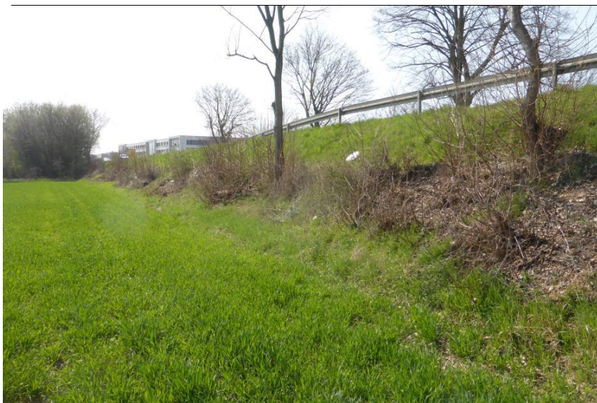
Abb. 7: Böschung der Friedberger Straße
