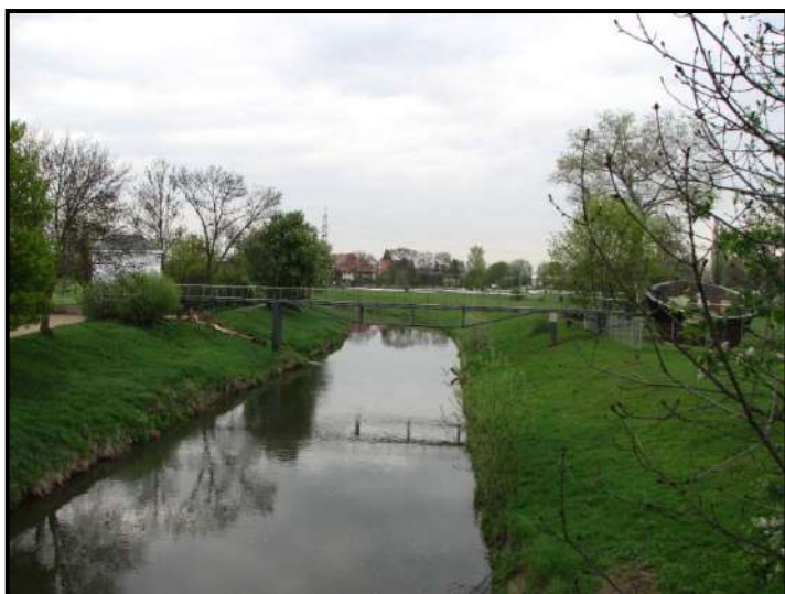
Abbildung 7: Blick nach Norden auf die Nidda von der Brücke Büdinger Straße
