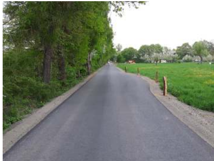
8- Zufahrtsweg Dottenfelderhof (Ausweichstelle)
