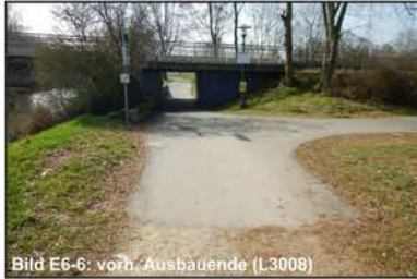
Bild E6-6: vorh. Ausbauende (L3008)
