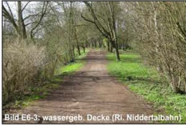
Bild E6-3: wassergeb. Decke (RI, Niddertalbahn)
