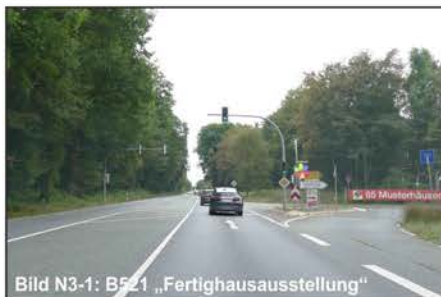
Bild N3-1: B521 „Fertighausausstellung“
