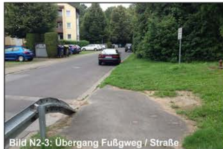
Bild N2-3: Übergang Fußweg / Straße
