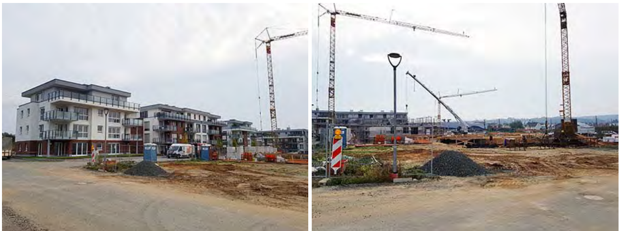
Abbildung 13: In Realisierung befindliche Wohnbebauung des Baugebietes „Im Schleid“
