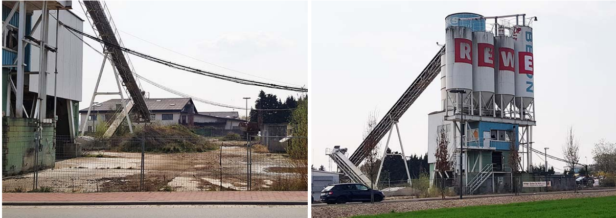
Abbildung 8: Gewerbliche Brachfläche mit ehemaliger Betonmischanlage im südlichen Teilbereich des Plangebietes
