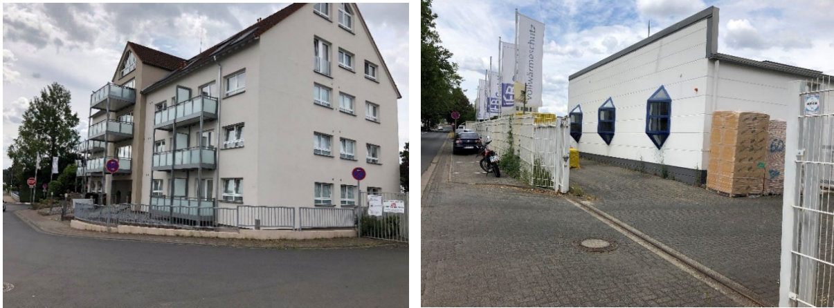
Abbildung 13: Fehlende Eingrünung entlang der Straßenfront Quelle: Eigene Aufnahme Büro GPM
