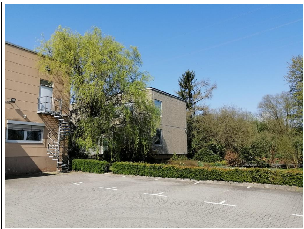
Abbildung 6: Gebäude und Gehölzbestand im Norden des Gewerbegebietes GE 1
