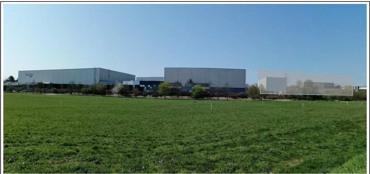
Abbildung 9: Östliche Gewerbebebauung und Gewerbegebiet GE 1 aus Richtung Nidda-Aue (grau = ungefähre Ausdehnung der geplanten Bebauung)
