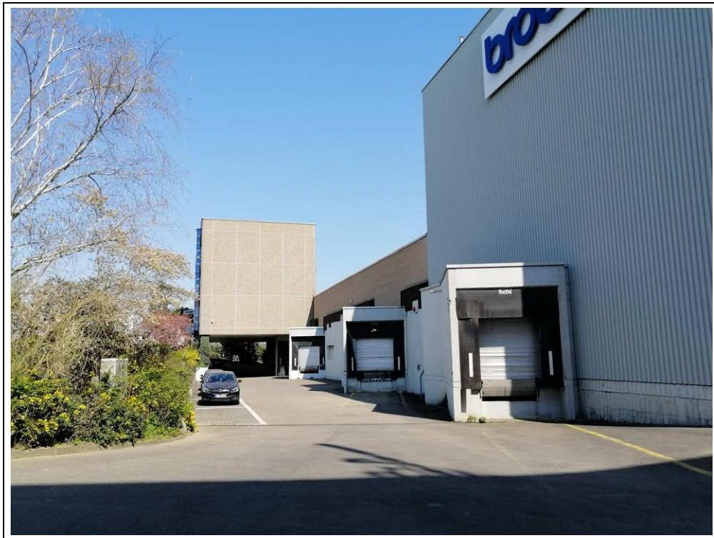
Abbildung 7: Bebauung im östlichen Plangebiet (GE 1)
