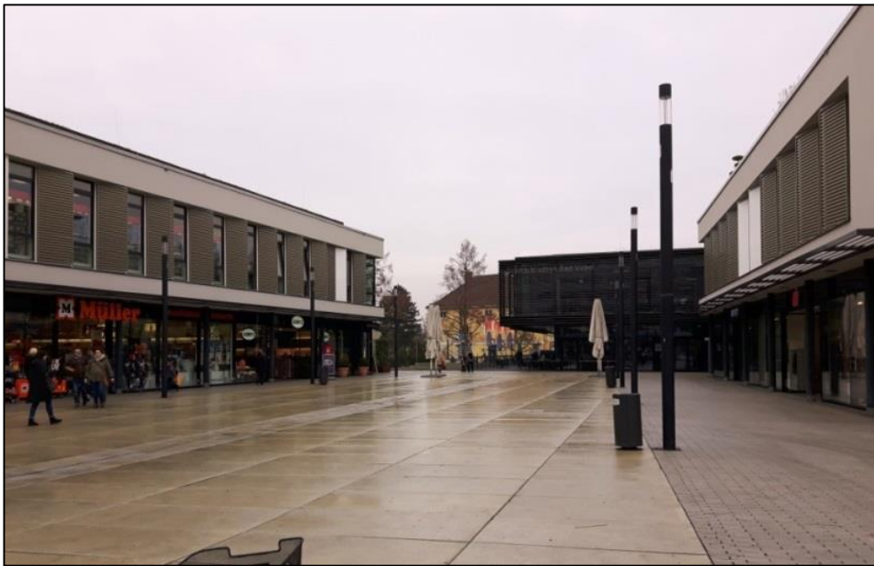
Abb.: Blick vom Niddaplatz aus Richtung Stadtbibliothek / Kurhaus
