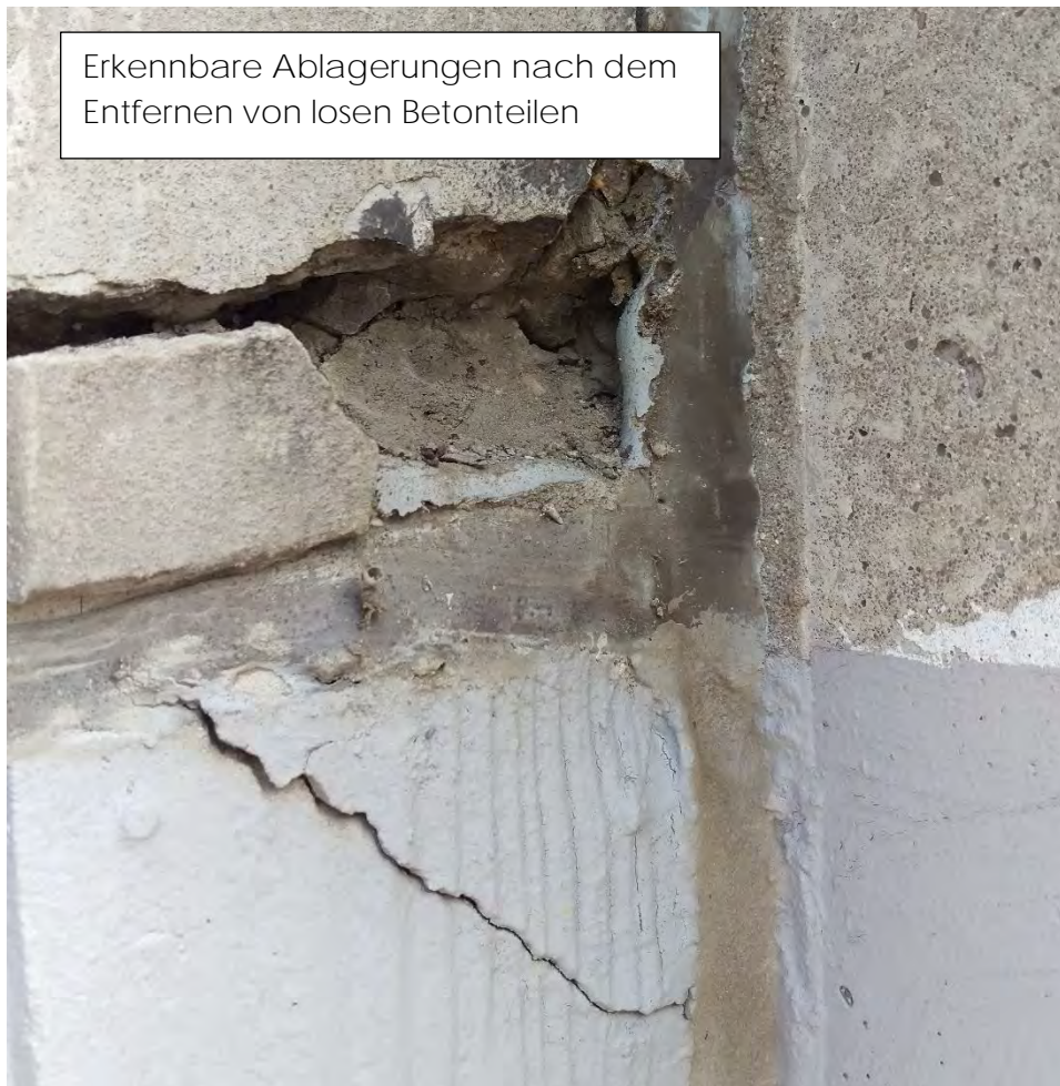
Abbildung 11 Anschluss Betonwand an Stütze
