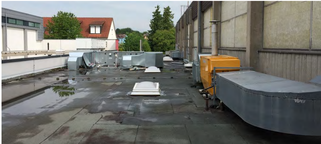
Anbau (westliche Hallenwand)
