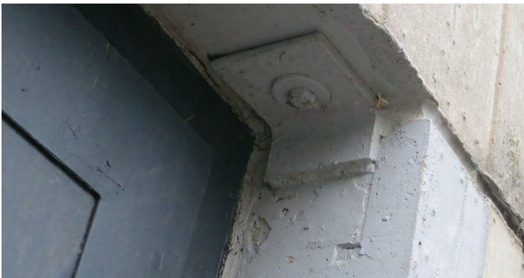
Abbildung 10 geschweißte/ geschraubte Winkelverbindung
