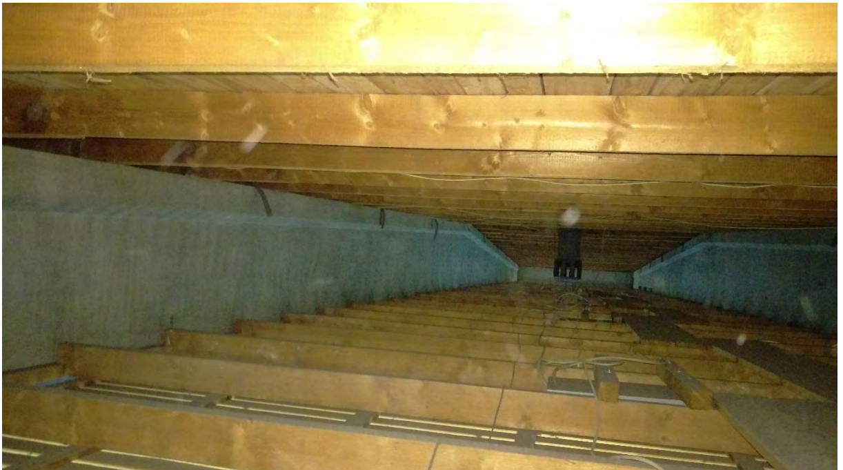
Abbildung 2 Blick zwischen Dach- und Unterdecke
