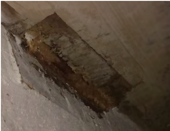
Abbildung 8 Schweißnaht vorhanden, Schweißnaht nicht erkennbar
