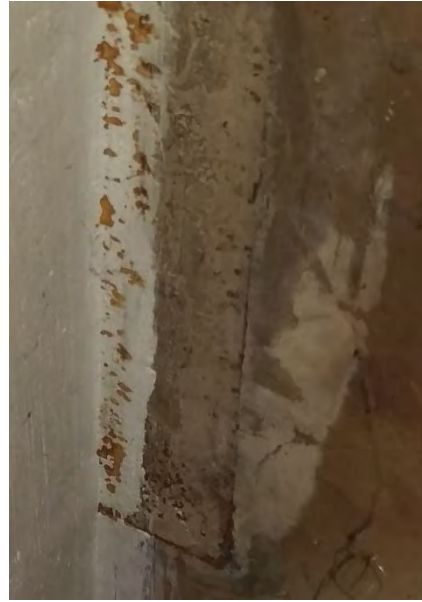
Abbildung 8 Schweißnaht vorhanden, Schweißnaht nicht erkennbar
