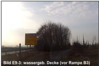
Bild E9-3: wassergeb. Decke (vor Rampe B3)
