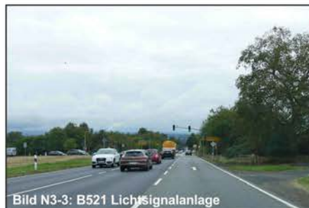
Bild N3-3: B521 Lichtsignalanlage
