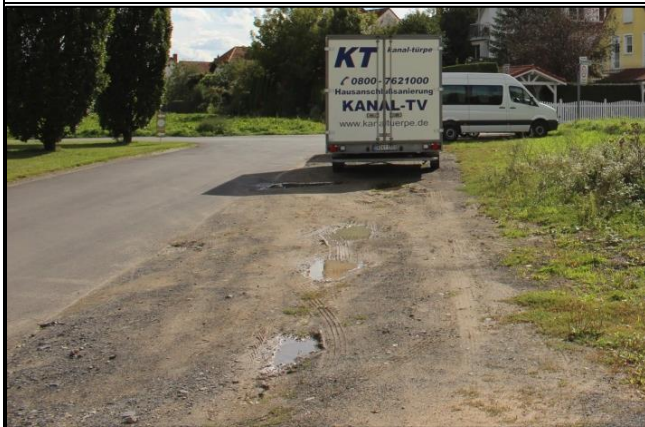
Foto 2: Schotterstreifen parallel des asphaltierten Weges
