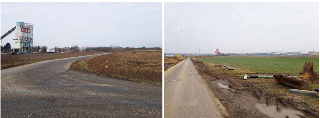
Abbildung 14: Baustraßen innerhalb des Plangebietes
