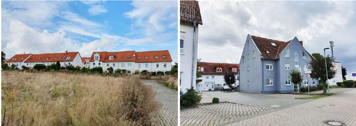
Abbildung 9: Reihenhausbauung (links) und Mehrfamilienhaus (rechts) im Norden des Plangebietes
