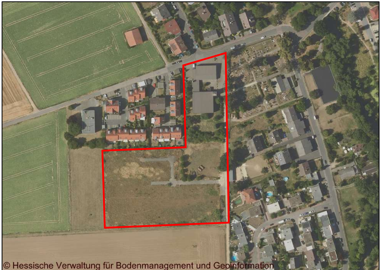
Abbildung 5: Heutiger Zustand des Plangebiets
