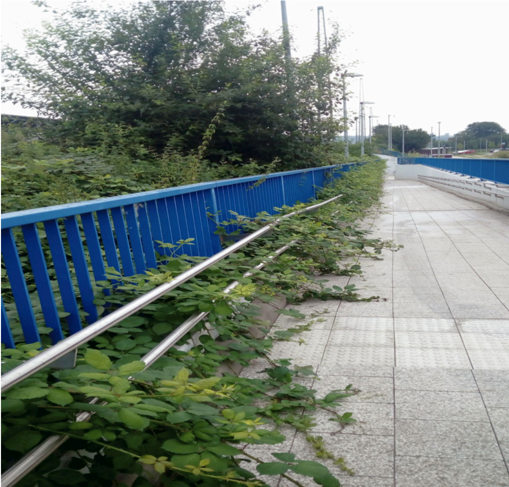
Foto, privat : Rampe Westseite Nordbahnhof
