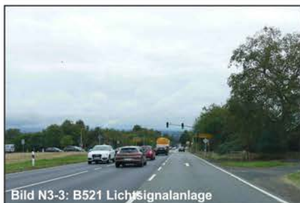
Bild N3-3: B521 Lichtsignalanlage
