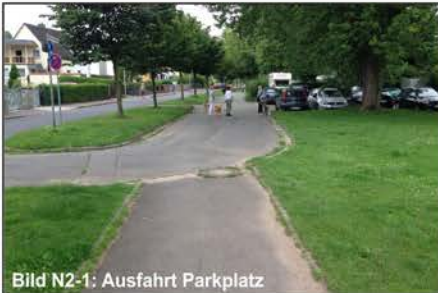
Bild N2-1: Ausfahrt Parkplatz
