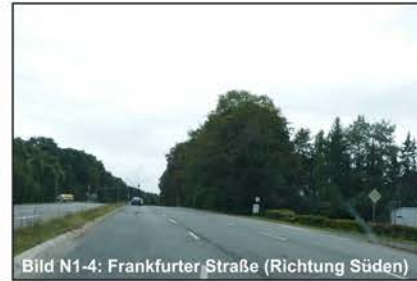
Bild N1-4: Frankfurter Straße (Richtung Süden)
