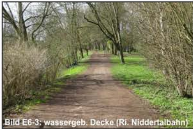
Bild E6-3: wassergeb. Decke (RI, Niddertalbahn)
