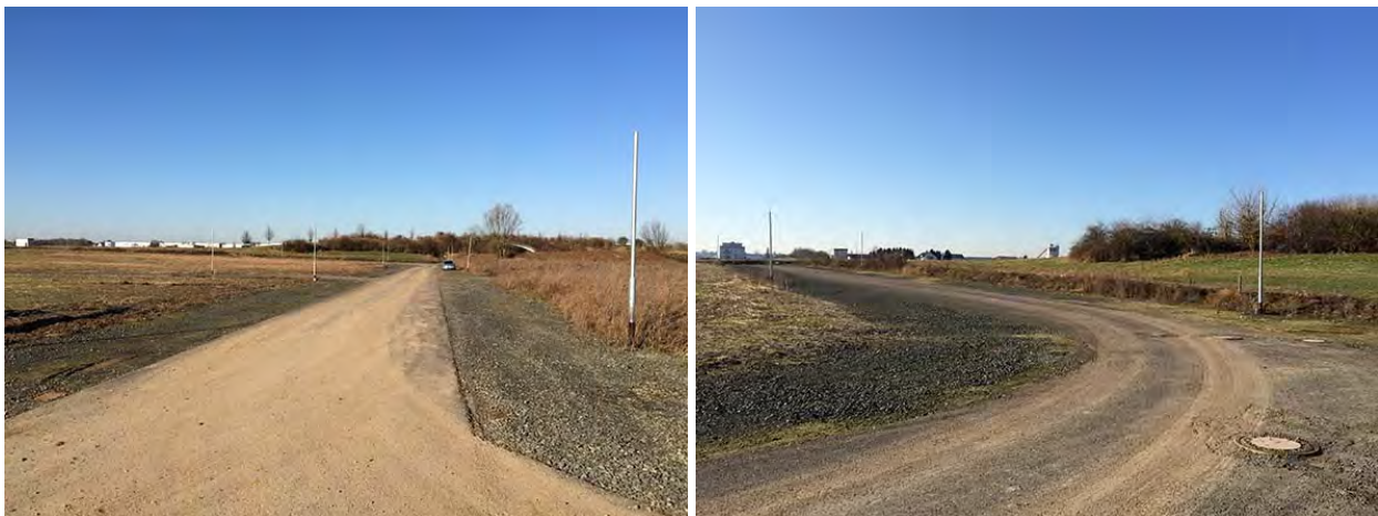
Abbildung 19: Bereits fertig gestellte Erschließungsstraßen im Plangebiet
