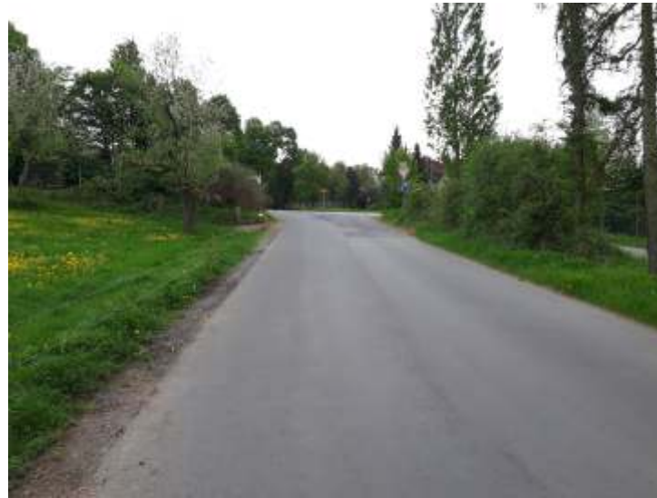
6- Zufahrt von Dottenfelderhof zur L3008
