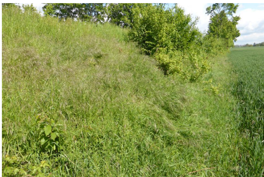
Abb. 9: Dichte Vegetation auf der Straßenböschung
