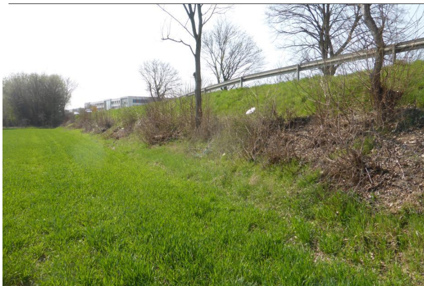
Abb. 7: Böschung der Friedberger Straße
