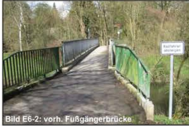
Bild E6-2: vorh. Fußgängerbrücke
