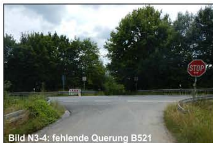
Bild N3-4: fehlende Querung B521
