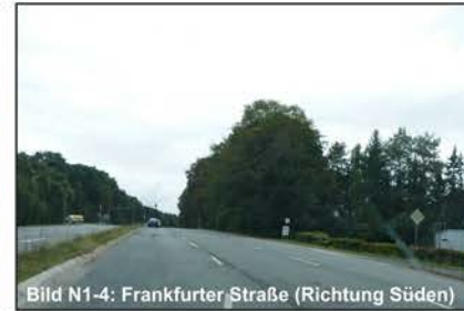
Bild N1-4: Frankfurter Straße (Richtung Süden)
