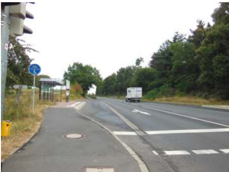
3- Büdinger Straße (L 3008) - Blick nach Osten
