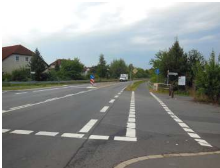
4- Büdinger Straße (L 3008) - Blick nach Westen
