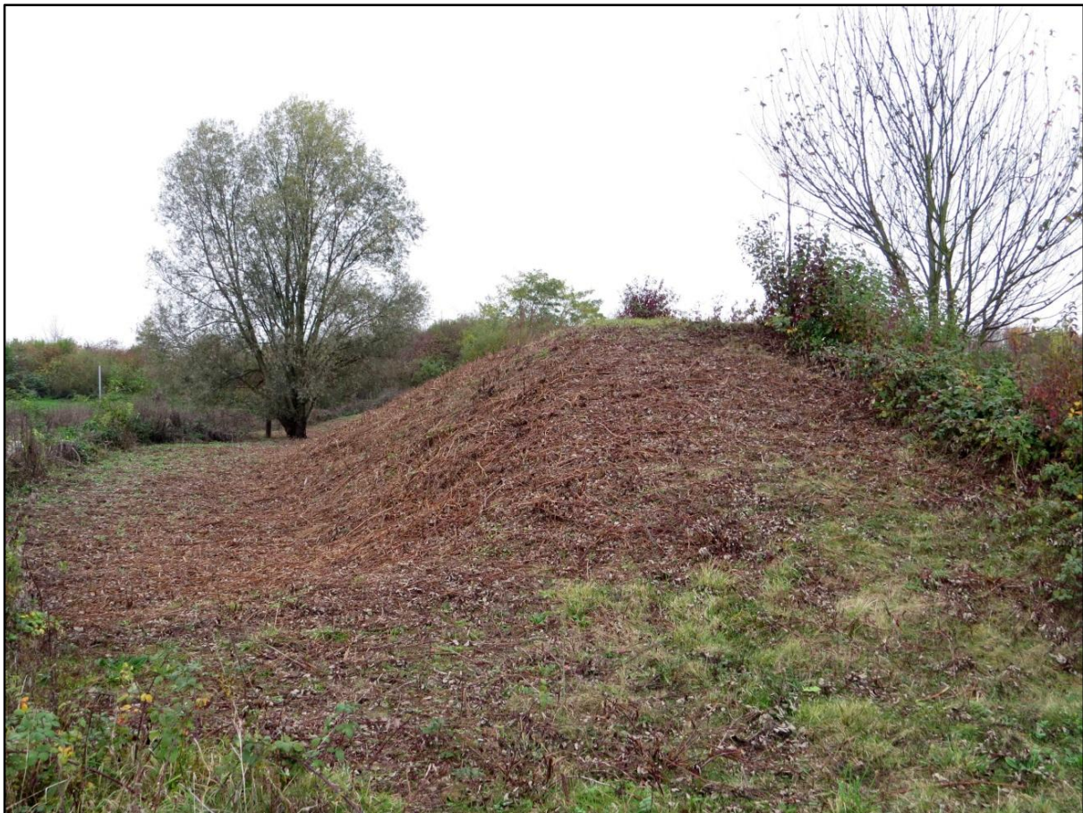
Abb. 2: Der Lärmschutzwall von Osten aus gesehen, 25. Oktober 2017
