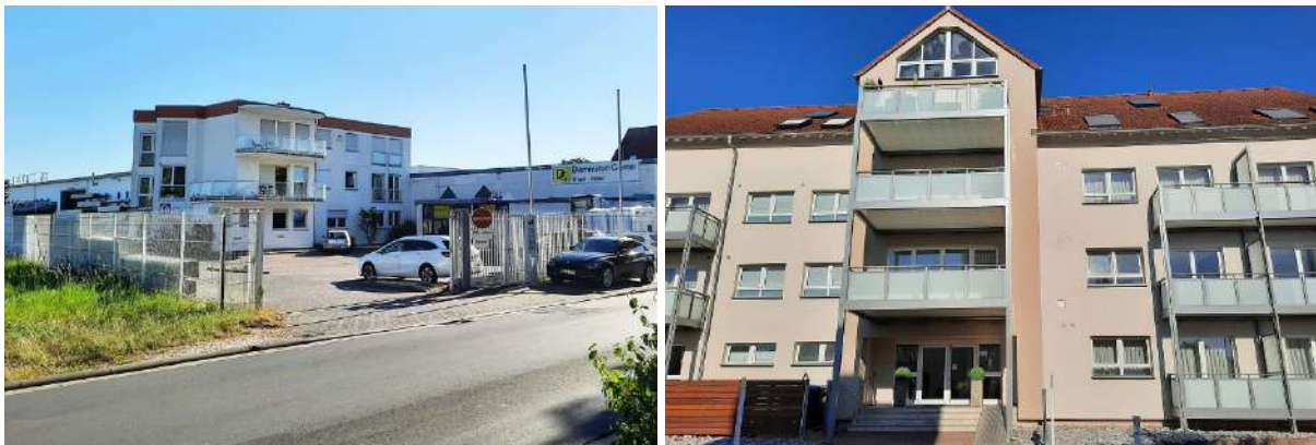
Abbildung 13: Dämmstoffcenter (links) und Hotel (rechts) südöstlich des Plangebiets
