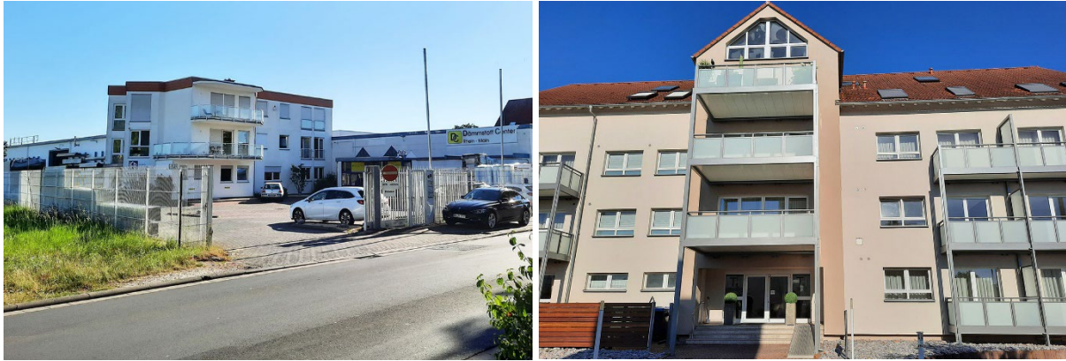
Abbildung 13: Dämmstoffcenter (links) und Hotel (rechts) südöstlich des Plangebiets Quelle: Eigene Aufnahme Planergruppe ROB GmbH
