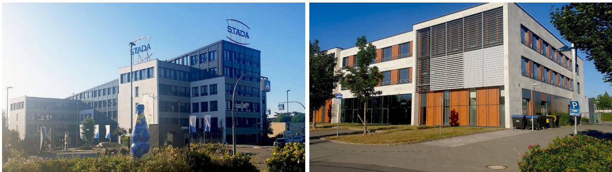
Abbildung 12: Stada Arzneimittel AG (links) und Europäische Schule Rhein Main (rechts) Quelle: Eigene Aufnahme Planergruppe ROB GmbH
