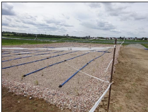
Abb. 12: Pflanzenkläranlage im Aufbau
