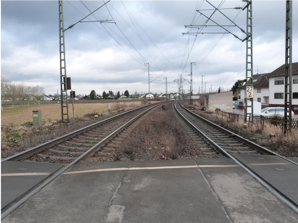
3.2. Strecke 4010 Blick in Richtung Bf Lampertheim (Mannheim)
