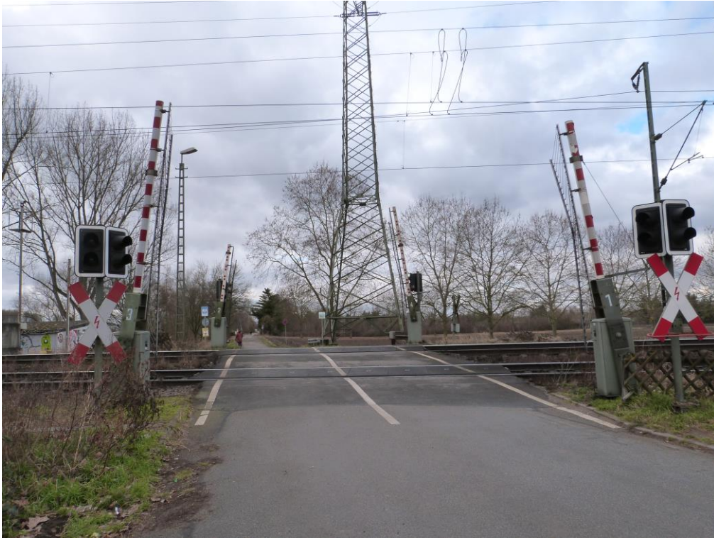
1.1. Blick in Richtung II. und III. Quadranten
