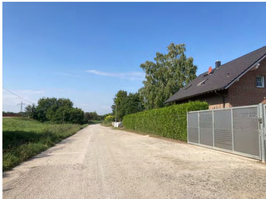
Gegenwärtiger Straßenausbau im südlichen Ast der Straße „Am Werrtor“
