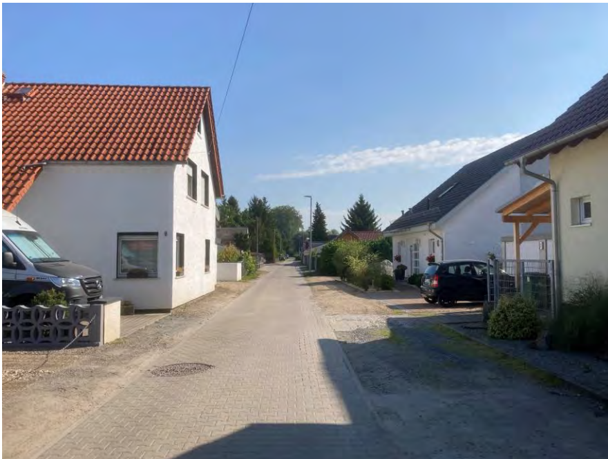
Gegenwärtiger Straßenausbau im nördlichen Ast der Straße „Am Werrtor“
