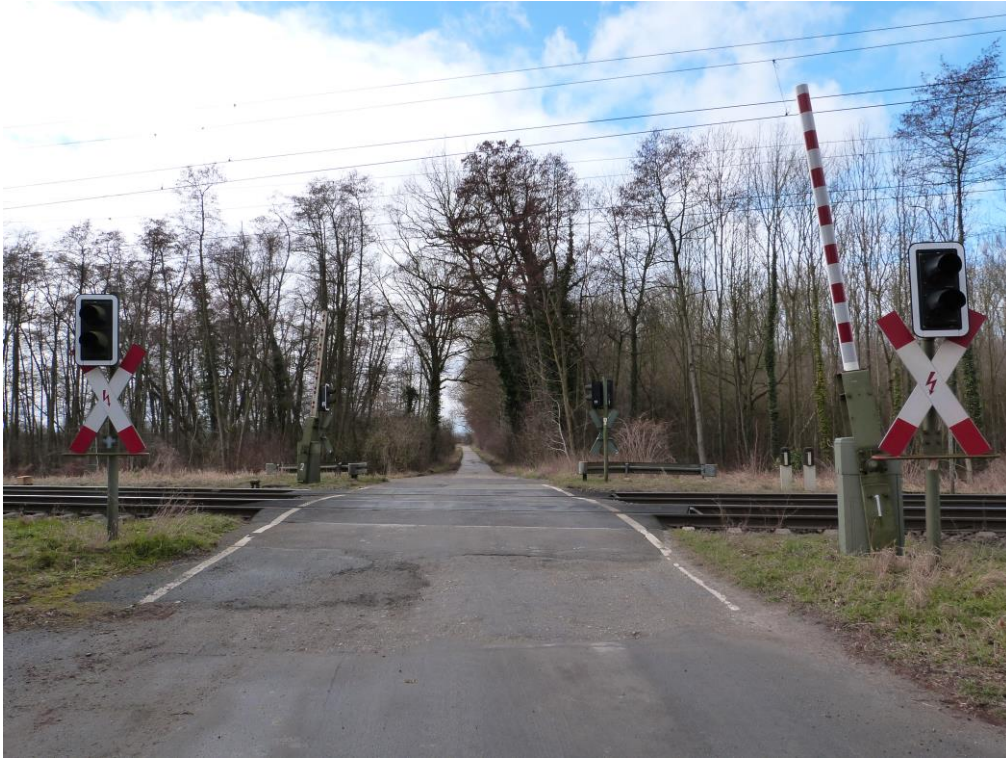
1.1. Blick in Richtung II. und III. Quadranten
