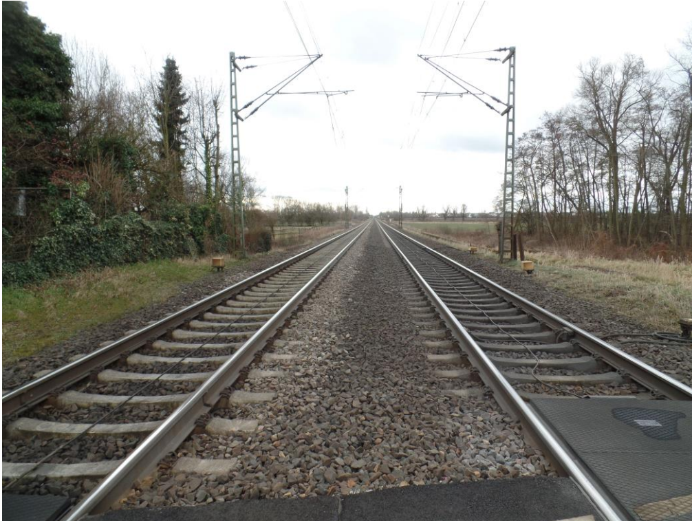
2.2. Strecke 4010 Blick in Richtung Bf Lampertheim (Mannheim)
