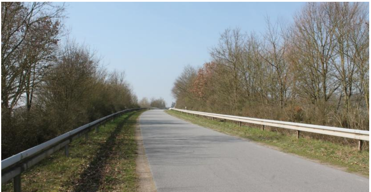
Abbildung 10: Bei den Böschungsbereichen der Straßenbaukörper dominieren standortgerechte Laubgehölze, die hier überwiegend als Erosions- und Emissionsschutz dienen.
