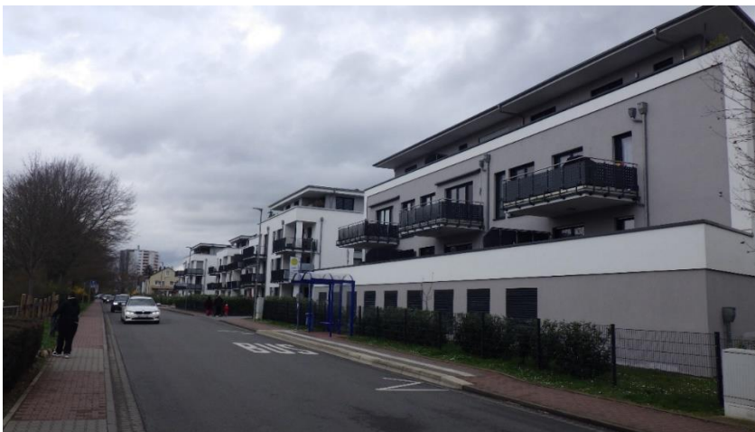
Abbildung 9: Östliche Bebauung (Quelle Planungsgruppe Darmstadt, 2024)
