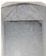
Innendach mit Rückzugswinkel für Fledermäuse
