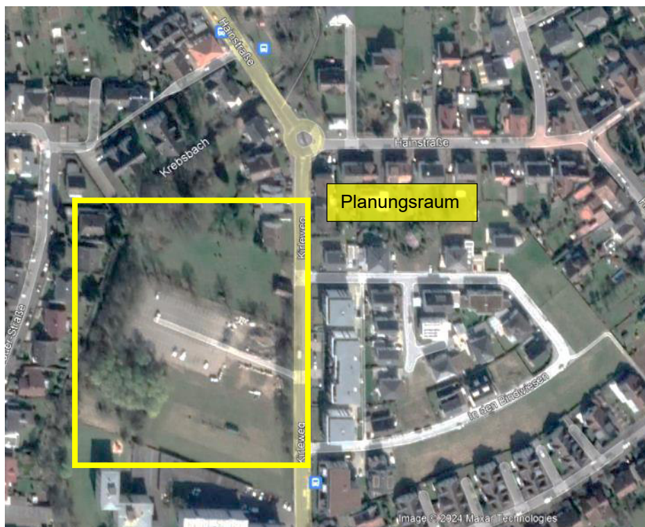
Abbildung 13: Im Osten auf den entsiegelten Flächenteilen erkennbare Bauarbeiten. Luftbild aus dem Jahr 2022. Quelle: earth.google.de.
