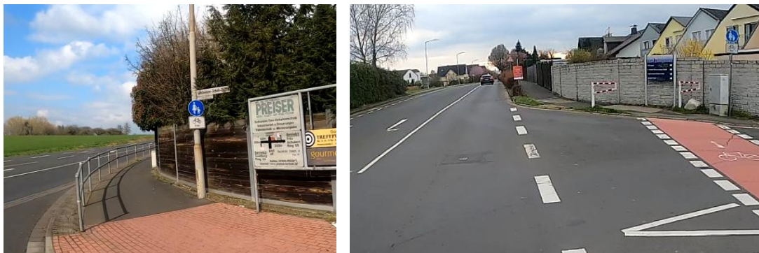
Abbildung 13: keine ausreichenden Gehwegbreiten für Benutzungspflicht Radverkehr (links: Geschwister-Scholl-Straße, rechts: Hammersbacher Straße)
