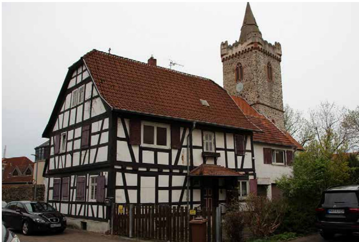
Abb. 50: Gebäude in der Martin-Luther-Straße 4
