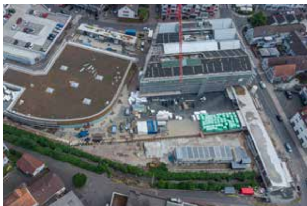
Abb. 43: Blick auf den entstehenden neuen Stadtplatz
